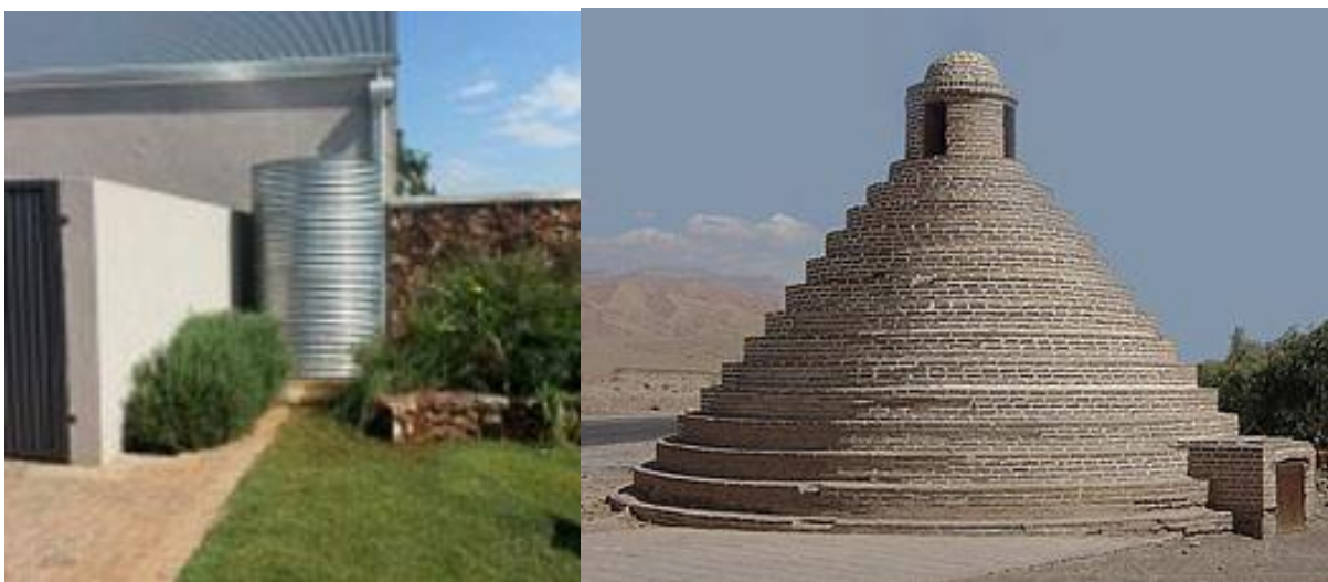
تصویر ۴۲: آب انباری قدیمی، و نمونه ای از یک روش جمع آوری آب باران در عصر حاضر
