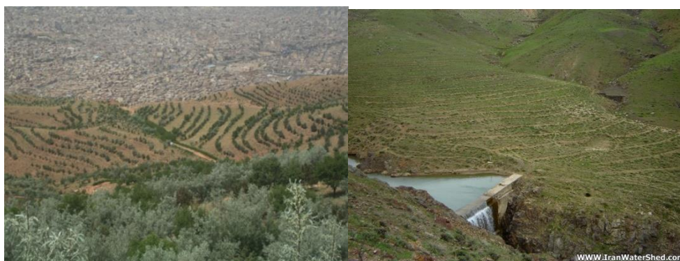
تصویر ۴: بانکت بندی و ساخت چکدم بتنی دو سازه مکمل یکدیگرند، و کنتور بنک
