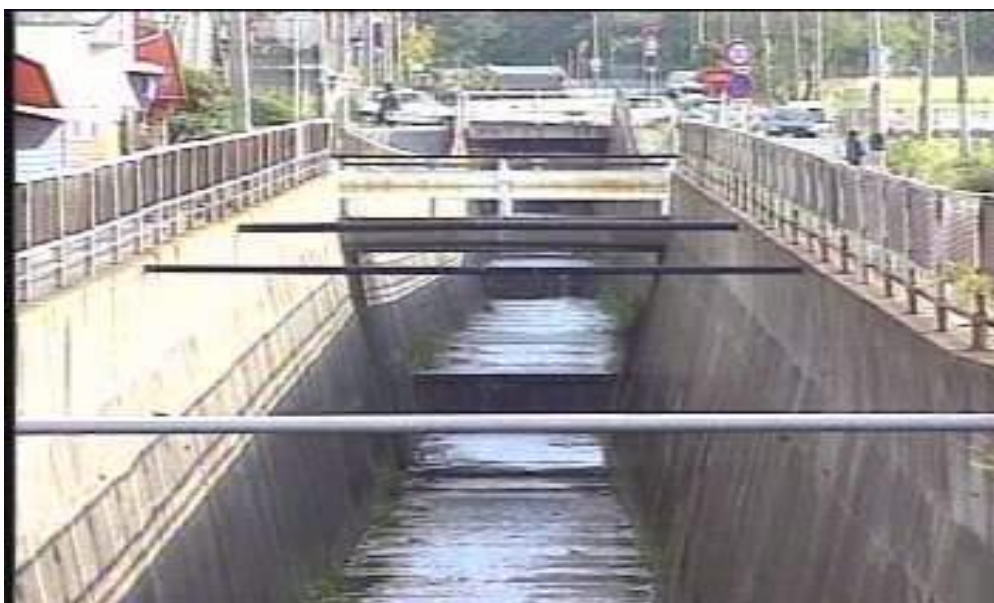
تصویر ۲۷: سیل بند با دیواره بتنی که عمدتاً "جهت جلوگیری از تخریب اماکن شهری به کار می رود
