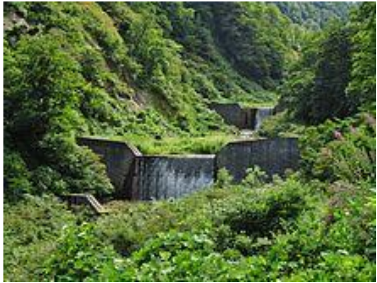
تصویر ۱۸: یک سری سد پنجه به پاشنه جهت کاهش سرعت جریان در آبراهه (تصویر از نگارنده)
